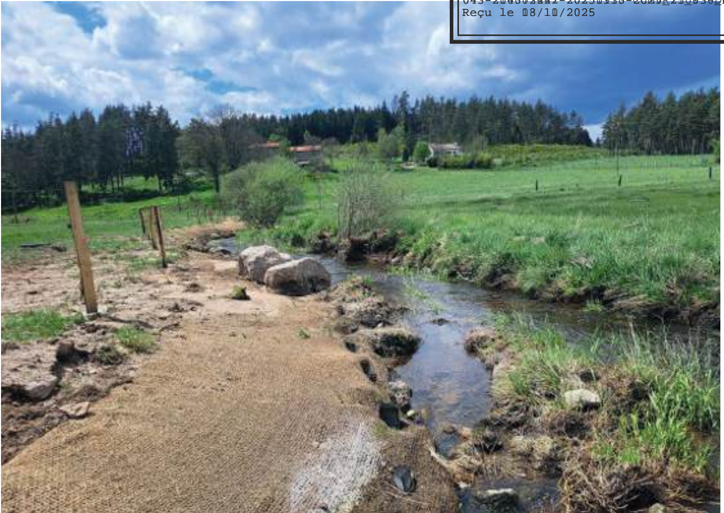
restauration du cours d'eau Chansou - Saint-Pal-de-Mons
