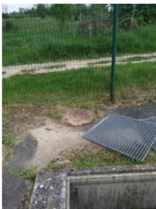
Regard amont dessableur
