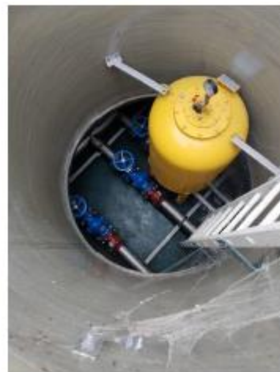
Chambre de vanne et ballon anti-bélier
