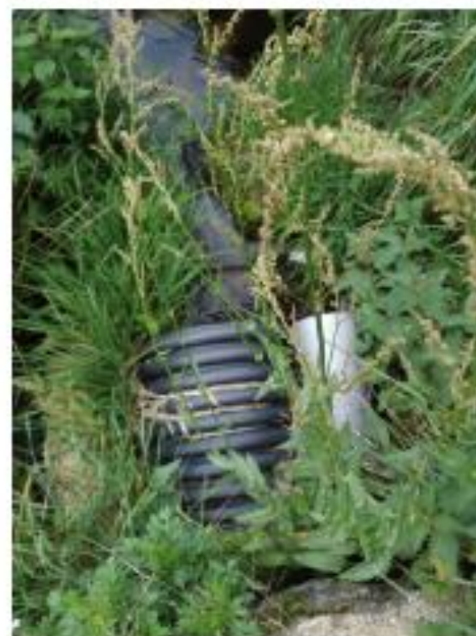
Exutoire du trop plein
