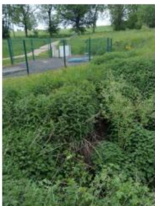
Exutoire du trop plein du dessableur
