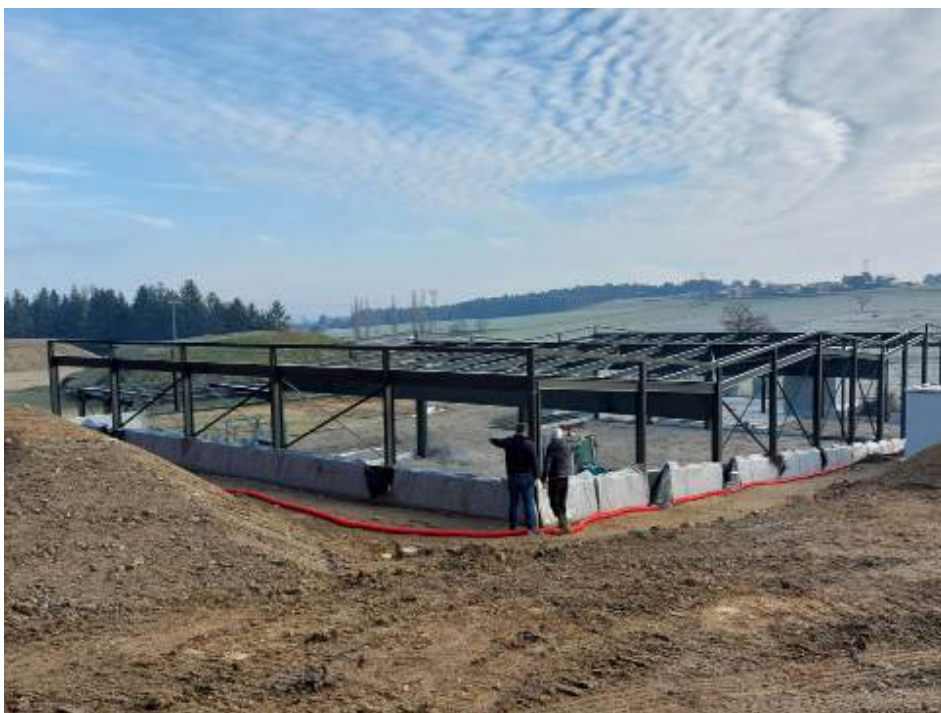
Chantier du Centre de tir à l'arc à Beauzac
